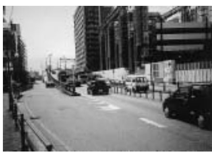
県道による歩行動線の分断により危険な横断があとをたたないダイエー前付近
